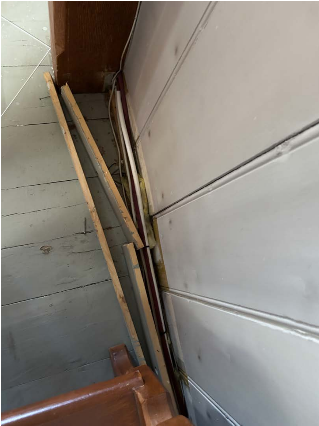
Åpnet kasse til rørføring til saksristi, provisorisk varmekabel lagt her. Bildet er tatt i bakkant av koret i kirken.
