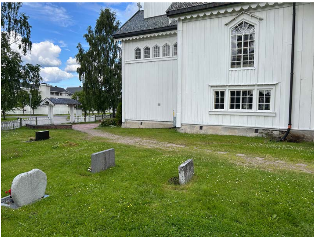
Kum til hovedvanntilførsel venstre billedkant. Vannledning ført inn i kirkebygget i mur til høyre for vindu.
