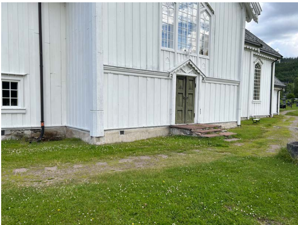
Sørvegg, trapp sideskip.
