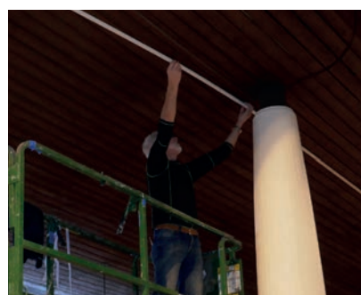
Bjørnar Vesterdal monterer kabelkanal i taket
