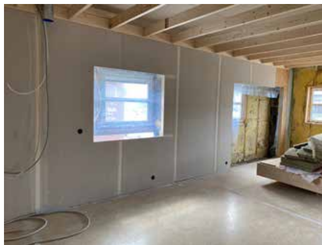
Det innvendige bygget gjennomgår en full renovering
