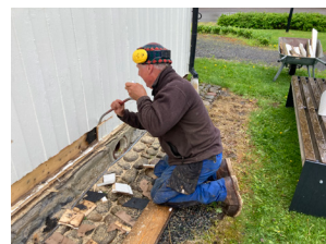
På tide å få gjort noe med dette, sier Finn Rune Stabell, som er i gang med å avdekke de utvendige råteskadene.
