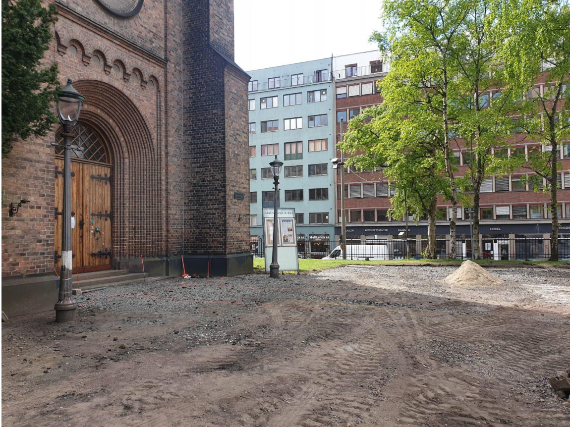
Bildet av arbeidet utenfor kirka.
