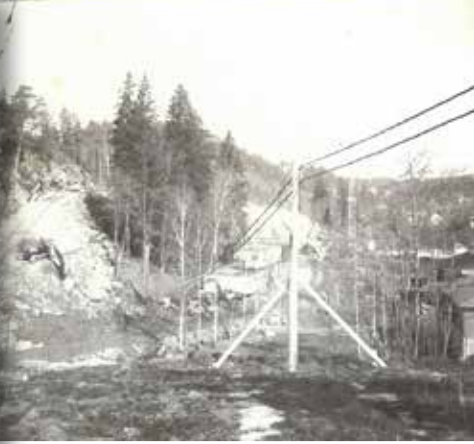
Asperudveien under opparbeidelse. (Oktober 1980)
