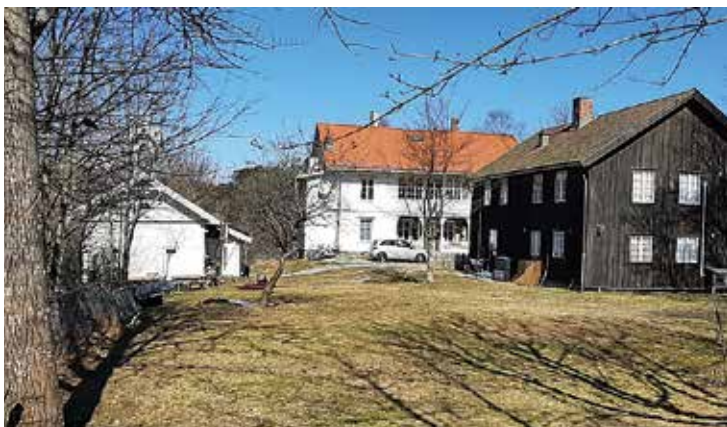
Tunet på Hauketo gård sett fra sør. Stabburet med stabbursklokka til venstre, svalgangshuset til høyre og våningshuset i bakgrunnen. Bak stabburet stikker en liten, ny uthusbygning frem. Den er ikke en del av det fredete tunet på gården.
