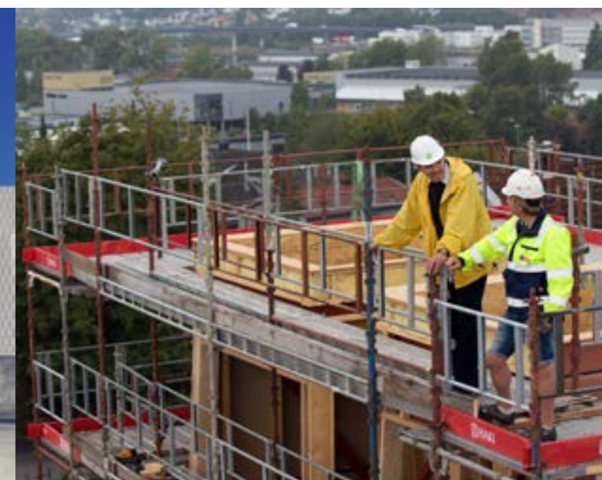
Espen Surnevik på byggeplassen i Porsgrunn. Foto: Michel Tran Nhat Vo
