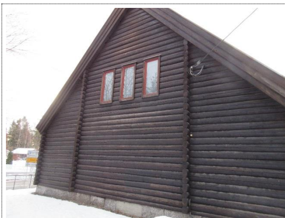
Bilde nr. 8 Nordgavlen med tre vinduer som er forblendet på innsiden.
