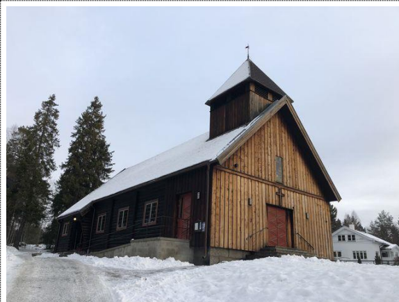
Bilde nr. 26 Yttertaket er tekkt med skiferstein, mens tårnet har papptekking.
