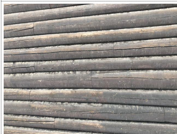
Bilde nr. 12 Ny overflatebehandling på samtlige yttervegger og klocketårn.
