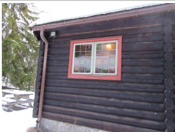
Bilde nr. 5 Kirken er laftet dvs. det er tre i de fleste bærende konstruksjoner.
