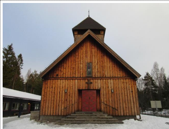
Bilde nr. 6 Inngangspartiet ble bygget om for ca. 10 år siden. Gavli i bindingsverk.
