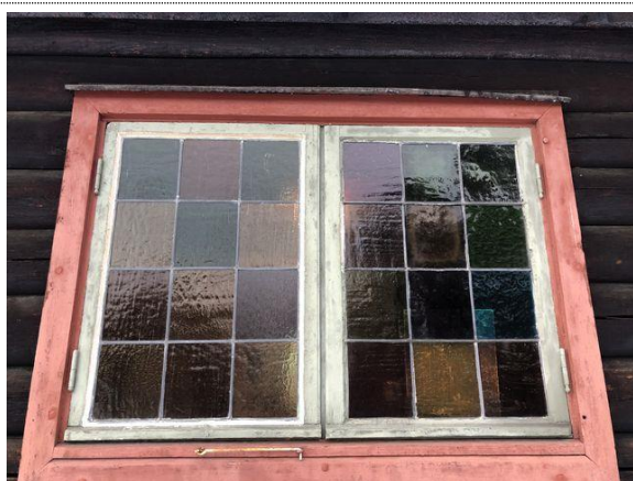
Bilde nr. 13 Ny overflatebehandling på samtlige vinduer og dører.
