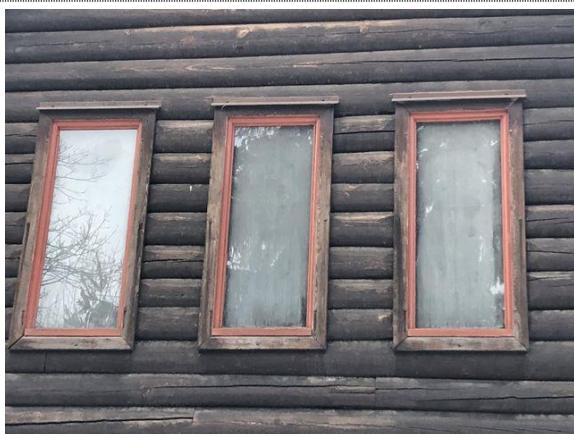
Bilde nr. 9 Fjerne forblending på innsiden av gavlvegg.
