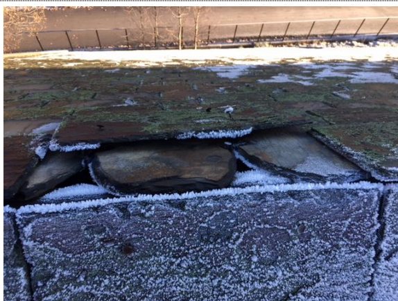
Bilde nr. 27 Omtrekking av yttertak med tilhørende detaljer. Bilder fra kommunens befarings i høst.
