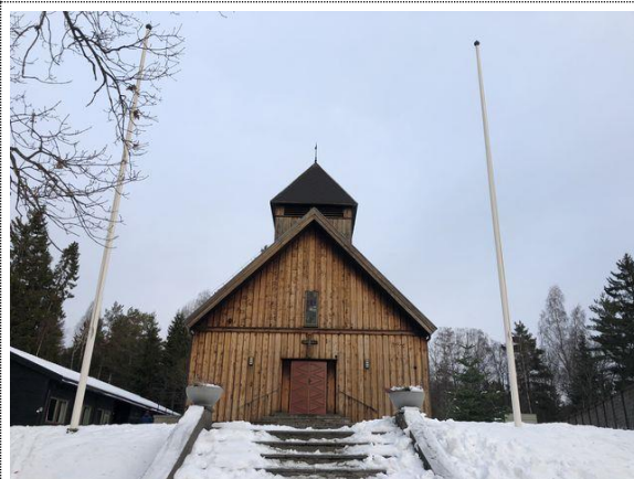
Bilde nr. 42 Det er skifersteinsbelagte trappetrinn fra parkeringsplass og frem til bygningen.
