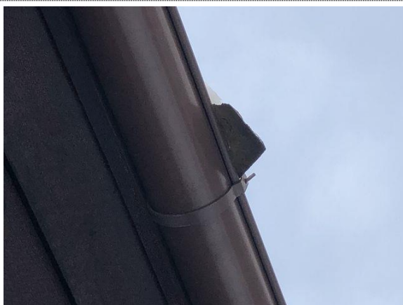
Bilde nr. 25 Sikre område langs langvegger.
