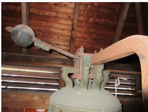
Bilde nr. 29 Sandblåse og galvanisere bærende detaljer for kirkeklokken.
