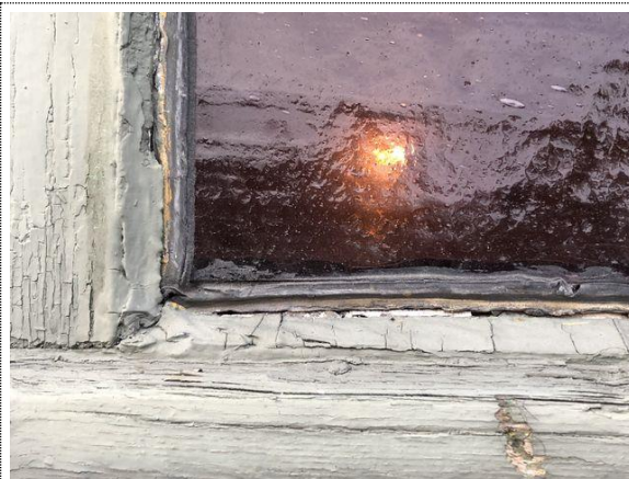
Bilde nr. 14 Ny overflatebehandling på samtlige vinduer og dører.
