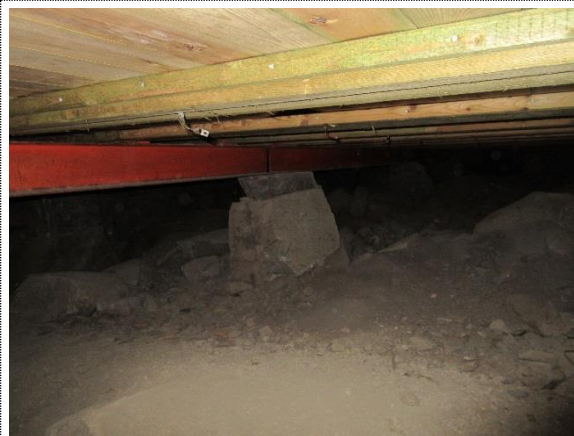
Bilde nr. 2 Det er punktfundamenter under kirken som understøttelse for blant annet ståldragere.
