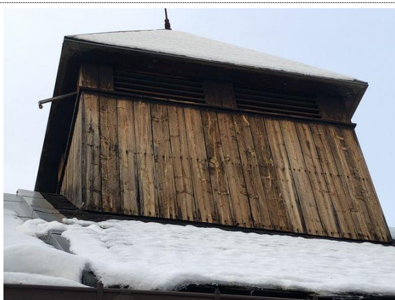
Bilde nr. 11 Ny overflatebehandling på samtlige yttervegger og klocketårn.
