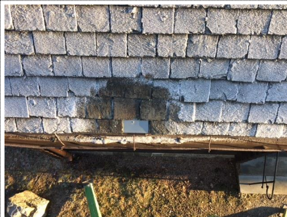
Bilde nr. 28 Omtrekking av yttertak med tilhørende detaljer. Bilder fra kommunens befarings i høst.
