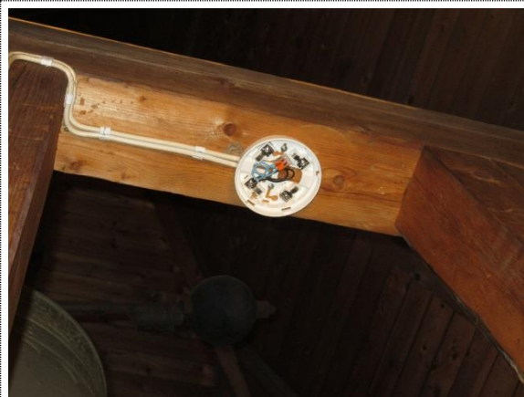
Bilde nr. 38 Istandsette/skifte sensor for brannalarm, delvis demontert i klokketårnet.
