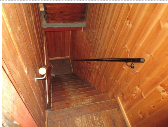
Bilde nr. 31 Slippe og lakkere innvendig trapp.
