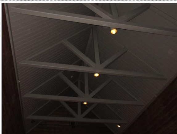
Bilde nr. 21 Himling i langskipet med en form for spot-armaturer.
