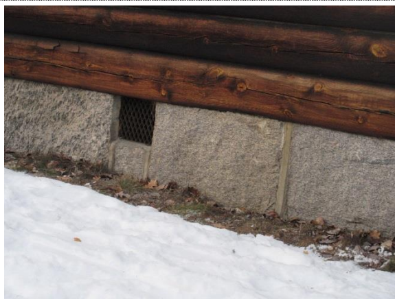
Bilde nr. 1 Kirken står på en grunnmur av granittblokker.
