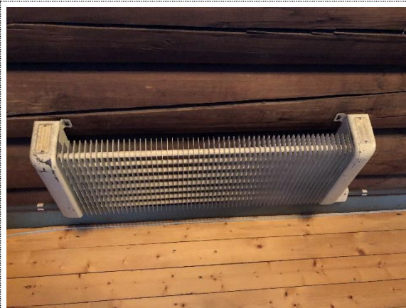
Bilde nr. 36 Utskifting av de eldste varmeovnene.
