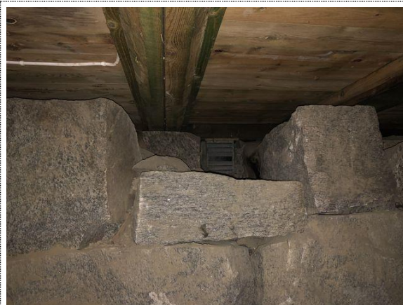
Bilde nr. 4 Sørge for god lufting av krypkjeller.
