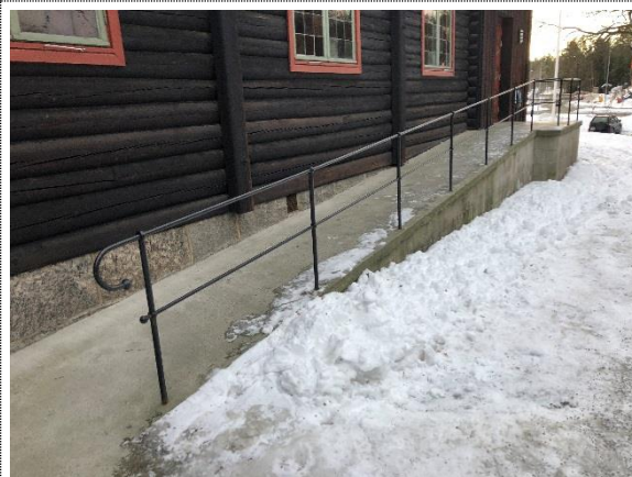
Bilde nr. 40 Rampe i betong for universelt utformet adkomst til kirken.
