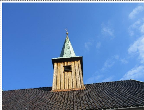
Bilde nr. 4 Også klokketårnet er kledt med panel. Hovedtaket er tekket med glassert takstein og klokketårnet med kobberbeslag.
