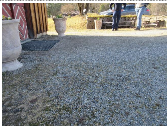
Bilde nr. 5 Gruslagt plass foran hovedinngang – lite fall.
