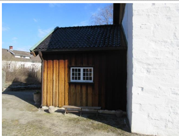
Bilde nr. 3 Tilbygg kledt tømmermannspanel.
