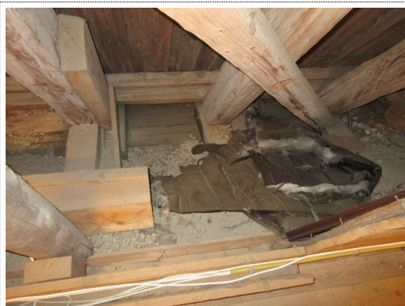
Bilde nr. 23 Stubbeloftleire i dekket mot skipet.
