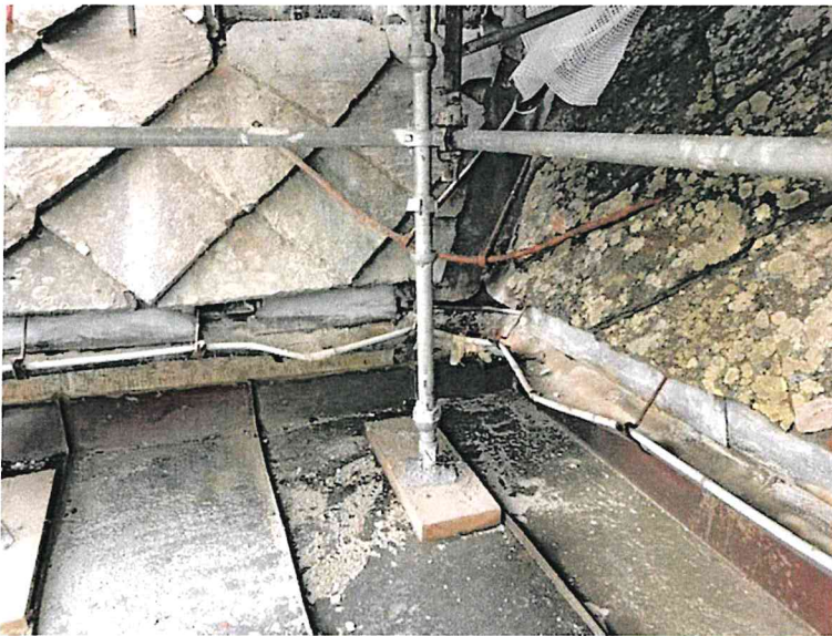
Bildet viser eksisterende takrenner og beslag
