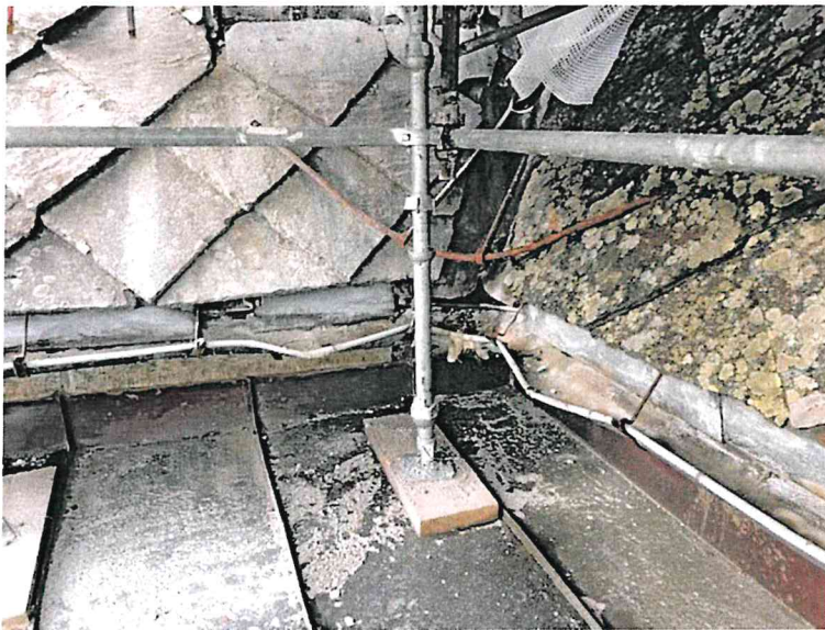
Bildet viser eksisterende takrenner og beslag
