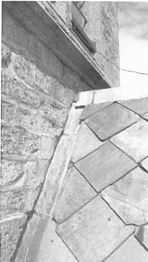
Fig 28: En takstein er i ferd med å løsne, og En takstein er skrudd fast med skruer midt i steinen.
