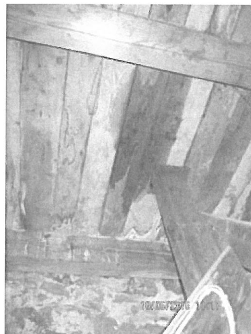
Figur 25. Lekkasje i tårn, som høyst sannsynlig skyldes at regnvann kommer inn gjennom treskoddene i toppen av tårnet.
