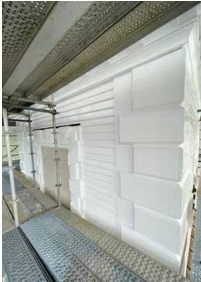
Solide stillas har vært avgjørende i arbeidet.
