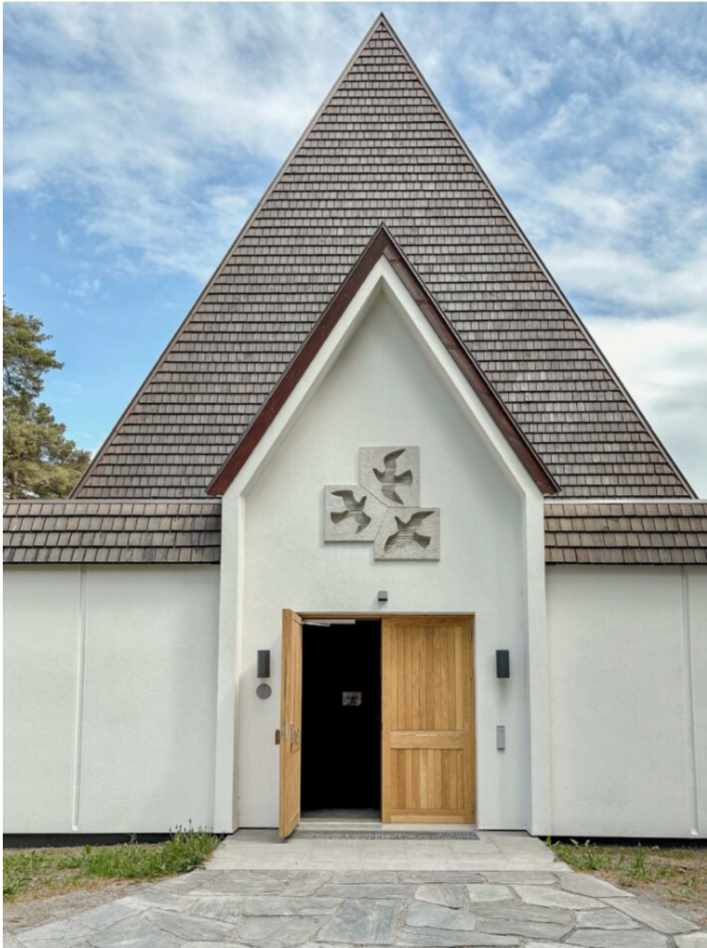
Hovedinngang Undersbo seremonibygg etter rehabilitering. Foto: Siri Lykke Kolstad, Asplan Viak AS
