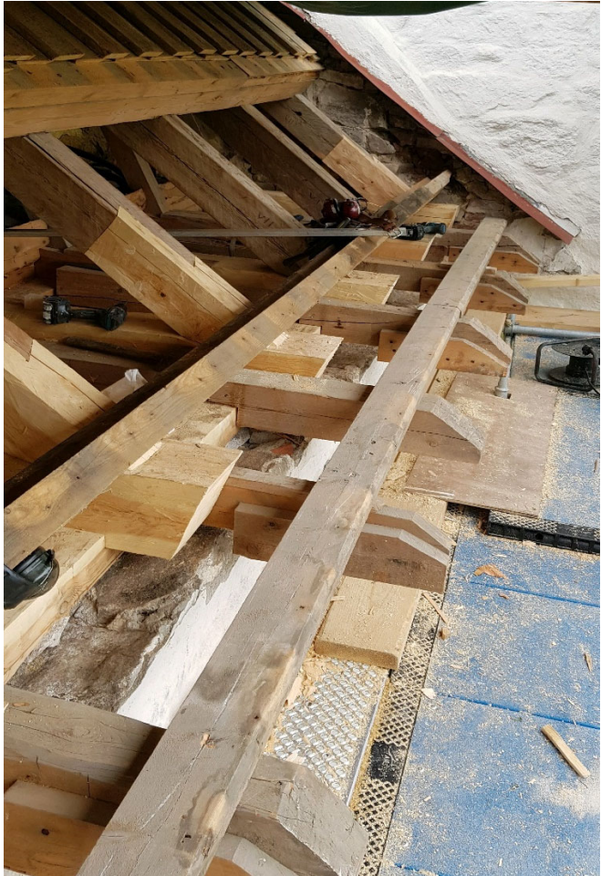
Det har ikke vært nødvendig med innvendige stillaser eller stempling. Råteskadene er i sin helhet reparert utenfra, på murkronene.
