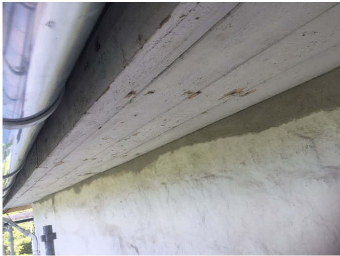
Øverst: Oppmuring av ytre veggliv, inntil ny murrem (her gjentas løsningen fra 1878). Nederst: Remontert gesims og kalkpusset veggliv.
