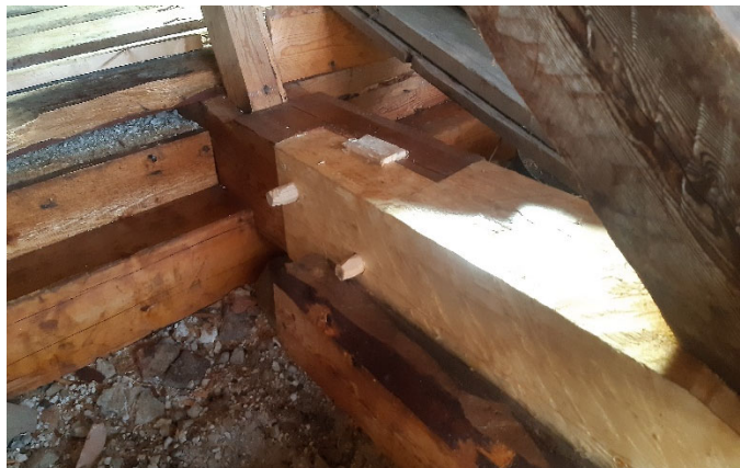
Eksempel på bladskjøt med løs kile og plugger: Kilen danner i praksis en kam og trekker samtidig skjøten tett sammen. Treplugger låser skjøten.
