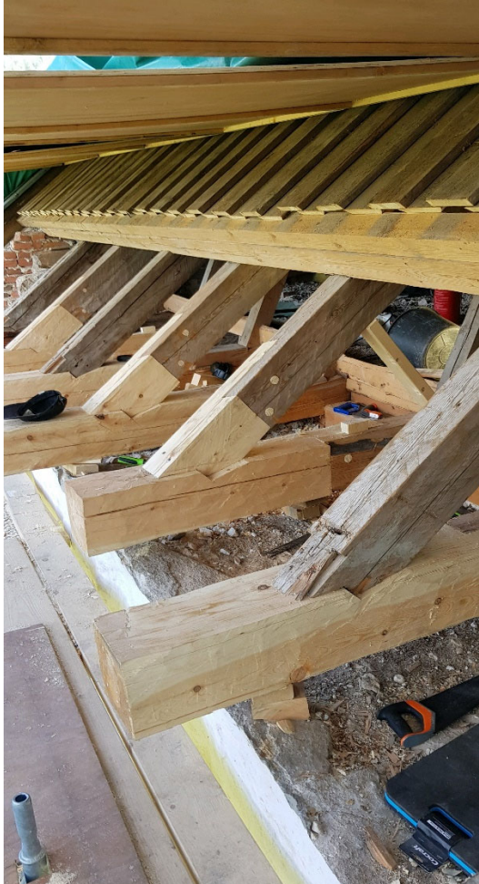
Eksempel på fullført reparasjon av loftsbjelker og taksperrer på korets sydvegg. Her gjenstår innlegg av ytre murrem.
