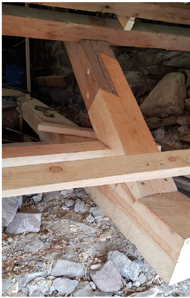
Eksempel på bladskjøting av taksperre med spisse ender; og sperrefot som står med dobbel forsats ned i loftsbjelken.
