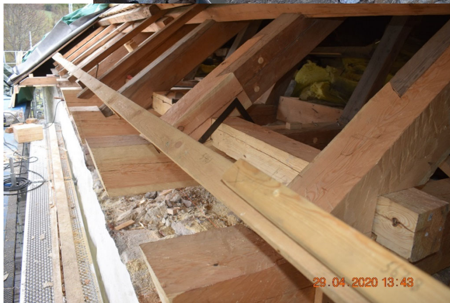
Kirkens takstol og opplegg er reparert i sin helhet, og har nå et tørt, ventilert og varig opplegg på murveggene.
