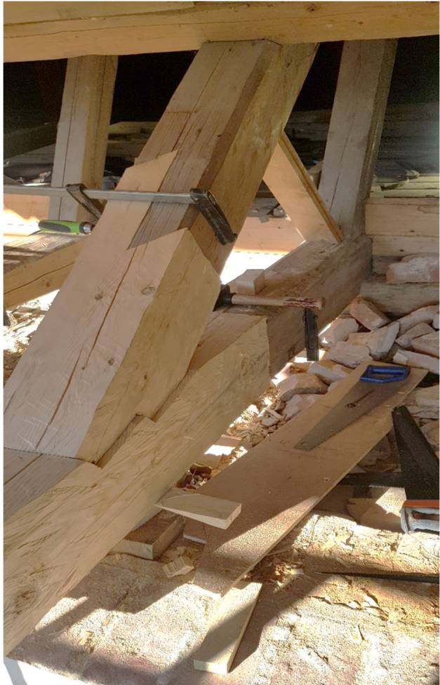
Reparasjonsarbeidet er i sin helhet utført utenfra: Eksempel på skjøt av loftsbjelke med ny del over murkronen. Over kirkerommet er loftsbjelken bevart in-situ.
