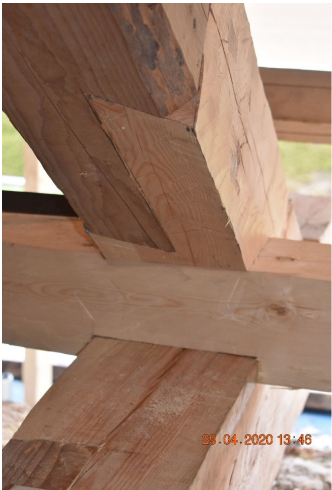
Eksempel på reparasjon og ny sammenføyning mellom murrem, loftsbjelke og taksperre.
