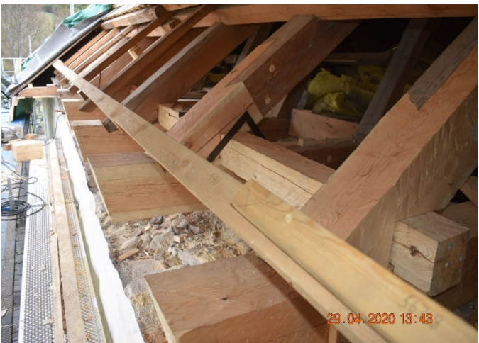
Øverst: Både sammenføyninger og murremmer var stedvis forsvunnet. Nederst: Samme sted etter sanering og reparasjon loftsbjelker og sperrer.
