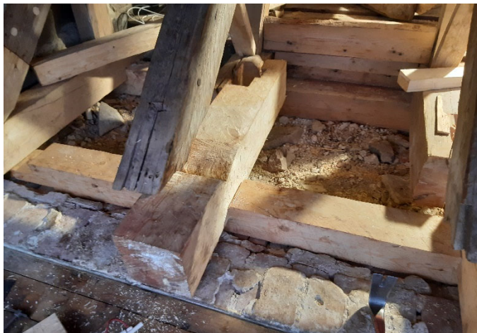
Øverst: Fra arbeidet med remontering av ‘puslespillet’ på korets nordvegg. Nederst: Samme sted med begge murremmer, loftsbjelker og sperrer på plass.
