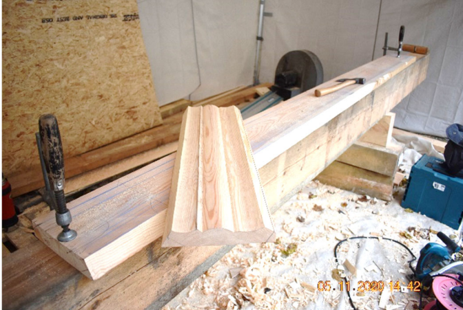
Alle nye materialer har samme kvalitet som de opprinnelige. Bearbeiding er også utført i tråd med de opprinnelige løsningene.
