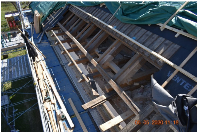
Øverst: Undertaket rengjort og klargjort for åpning. Nederst: Eksempel på en begrenset åpning ved takfoten for å komme til opplegget på murveggene.
