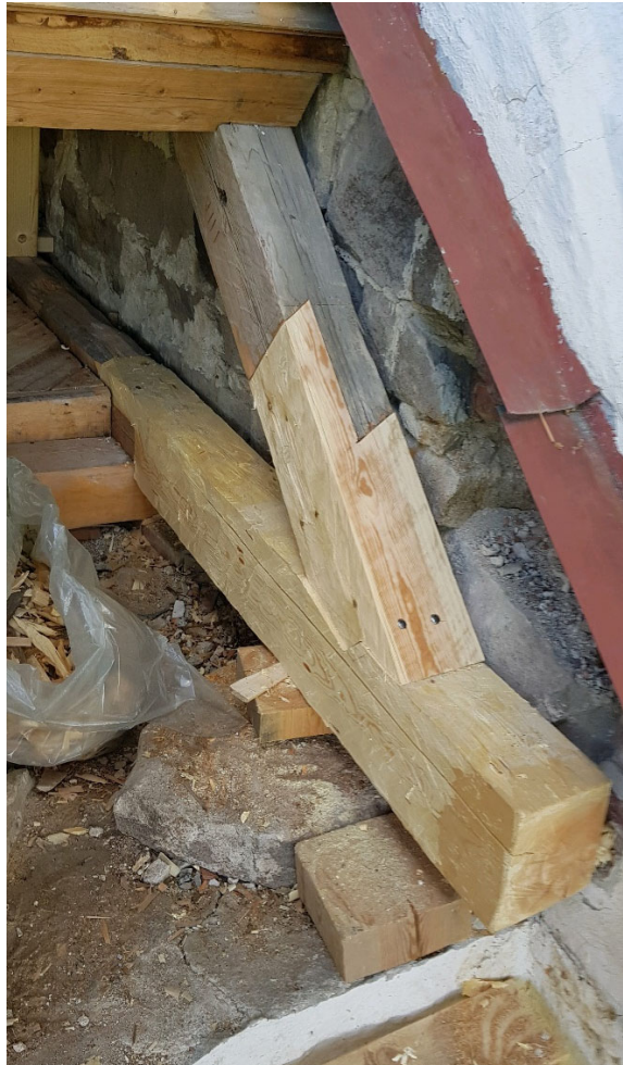
Eksempel på reparasjon av det typiske skadepunktet på murkronen: Forbindelsen mellom loftsbjelke og taksperre.
