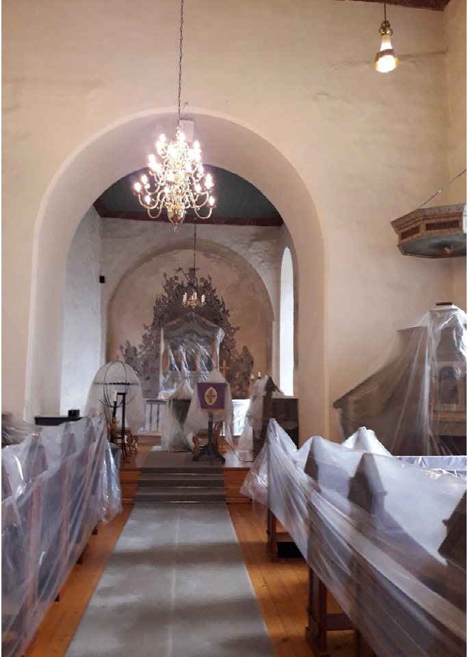
Det har vært fokus på et rent, ryddig og sikkert kirkerom. Konservator har kontrollert og dekket til etter arbeidets karakter og risiko for støv.
