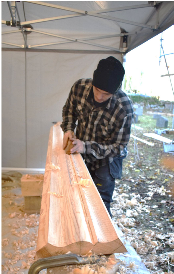
Både materialer og bearbeiding er basert på gjentakelse av de opprinnelige løsningene i konstruksjonen.
