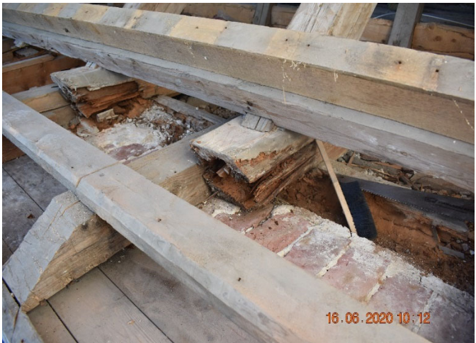
Øverst: Sanering av murkrone. Murremmer kunne stedvis støvsuges opp. Nederst: Eksempel på loftsbjelker med omfattende vednedbrytning.
