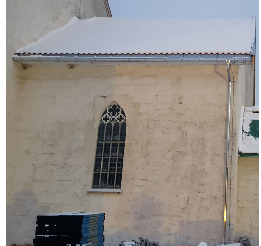
Fullført istandsetting av kirkens hovedtak over skip og kor. Her har det kommet nysnø på den nye yttertekkingen. Sakristiets tak vil bli omtekket i forbindelse med installasjon av slokkeanlegg i 2021.
