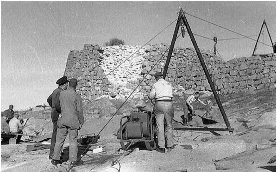
Restaureringen av Akerøy fort
