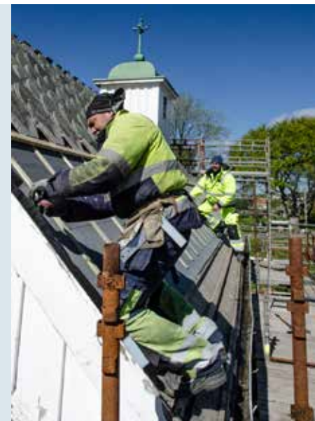
Anders Steinnes (foran) og Krzysztof Trzaskalski i arbeid på taket på Udland kapell.
