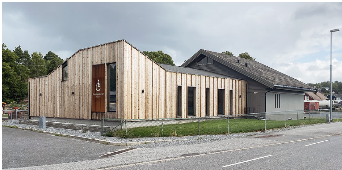
Våren 2022 stod dette tilbygget ferdig.
