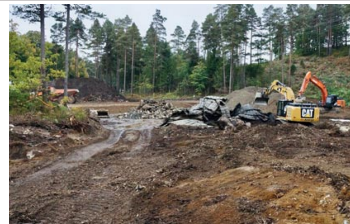
Oppå det brune jordlaget i bakgrunnen skal det 30 cm matjord som topplag. I dette området sto det mye vann. Nå er det sprengt i fjellgrunnen og drenggrøfter lagt ned slik at man får ledet vannet ut i kulvert langs veien.
