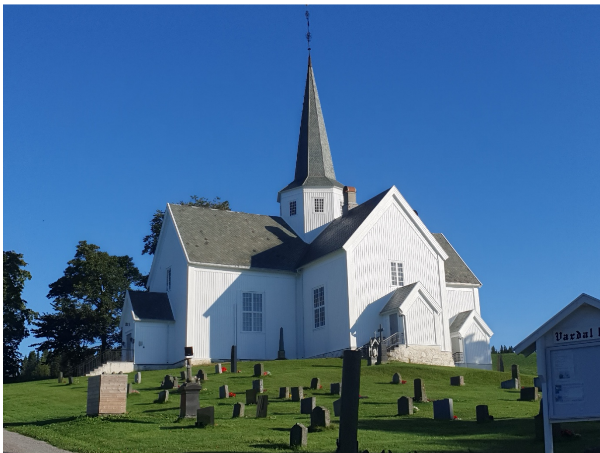
Vardal kirke ble malt og fikk reparert tak i 2025. Foto Line Langseth Bakkum
