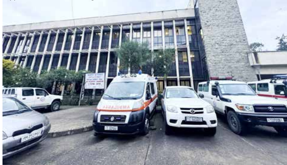
Zodito hospital i Addis Abeba. Heile 2. etasje har CBWCF fått til disposisjon. Den vert no rusta opp til brannskadeavdeling.
