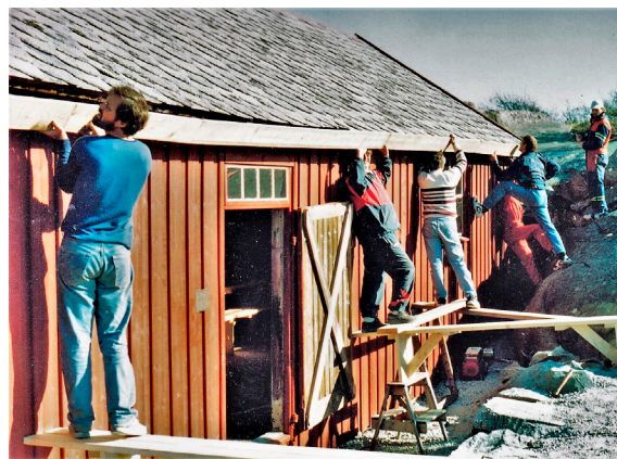
Det første prosjektet var å sette i stand Bøyenaustet 1994.
