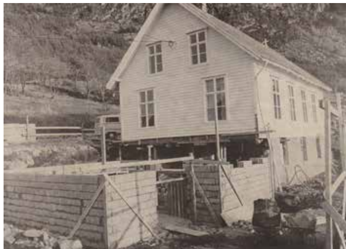
Her ser vi bedehuset slik det var frå 1913, og tilbygget som er under arbeid 70 år seinare.
