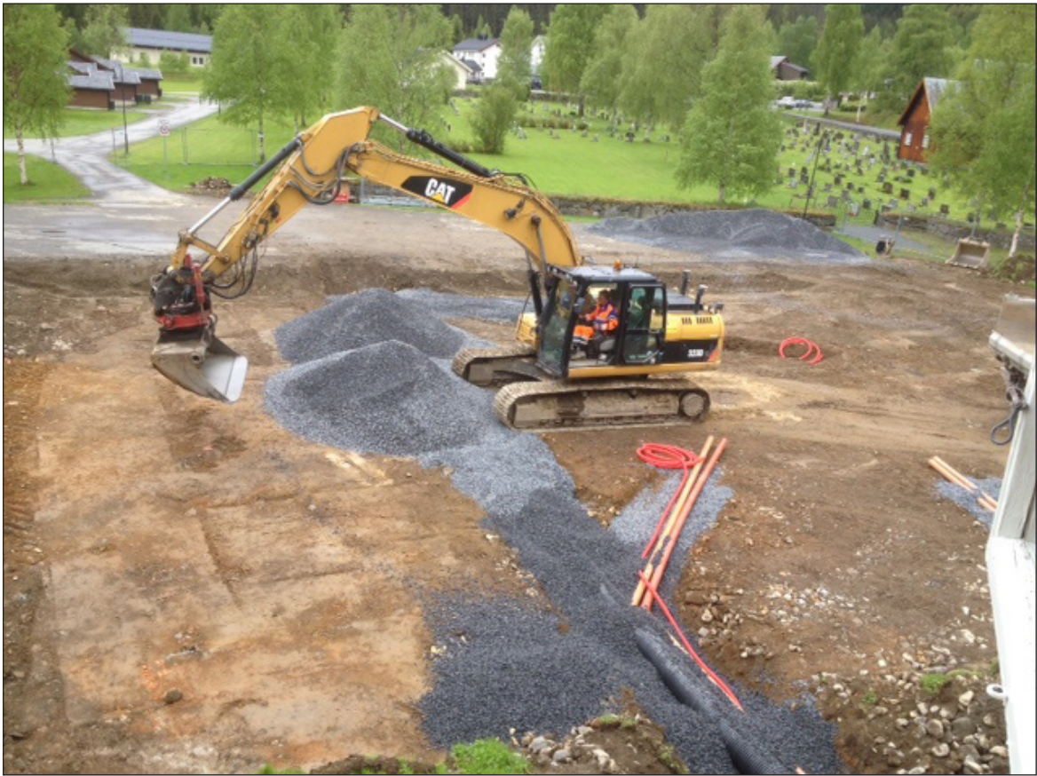
Snart reiser nytt helsehus seg på Bruflat, Martin Kompen i full gang med grunnarbeidet. Det starta i mai, bildet er take frå møterommet Hafsenn 3. juni.
