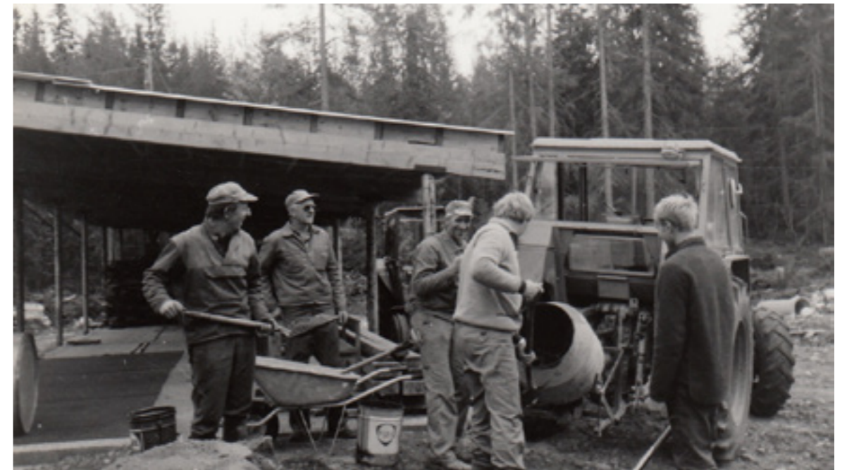
En glad gjeng i gang med å støpe anvisergrav i 1983. Fra v. Ole A. Hovde, Engebret Klevgård, Bjørn Rundberg, Tor Bjørnødegård og Knut Nysveen.
