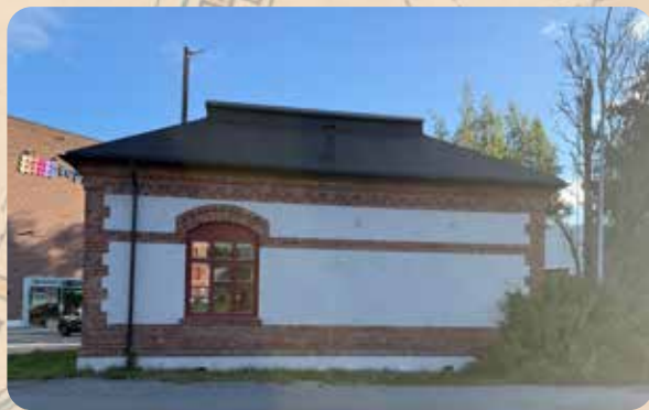
Bygget som ble brukt i forbindelse med Tangensporet eies av Bane NOR. Foto: Jorunn Wiik
