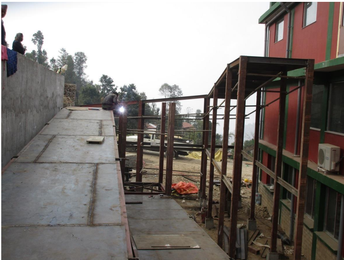
Arbeidet med rampene som skal gi bårpasienter tilgang til etasjene i det nye sykehusbygget pågår for fullt. Her gjøres sveisearbeider på stålrammene.
