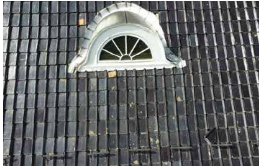
INSPEKSJON: På taket på Kongsdelene kirke skulle bare takstein rettes på. Da håndverkerne var oppe, oppdaget de råteskader som gjorde at undertaket knapt var der lenger. Foto: Asker kirkelige fellesråd
