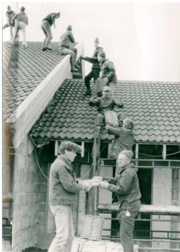
Dugnad da Arbeidskirken i Ås fikk lagt takstein, en lørdag i november 1983. Foto utlånt av Åsta Sørli.
