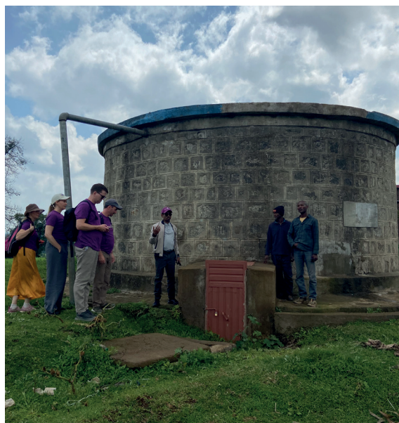
VANN FORANDRER ALT: I Shashamene, sør for Hawassa, fikk vi se hvordan vann pumpes opp fra bakken, samles i reservoarer og fordeles videre til nærliggende landsbyer. Anlegget vi besøkte gir tilgang på vann til hele åtte landsbyer.
