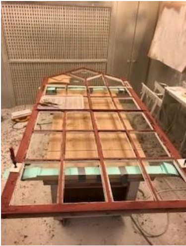
Bildet viser et av Båstad kirkes vinduer som er på snekkerverksted for restaurering. Foto: Jan Ivar Andreassen
