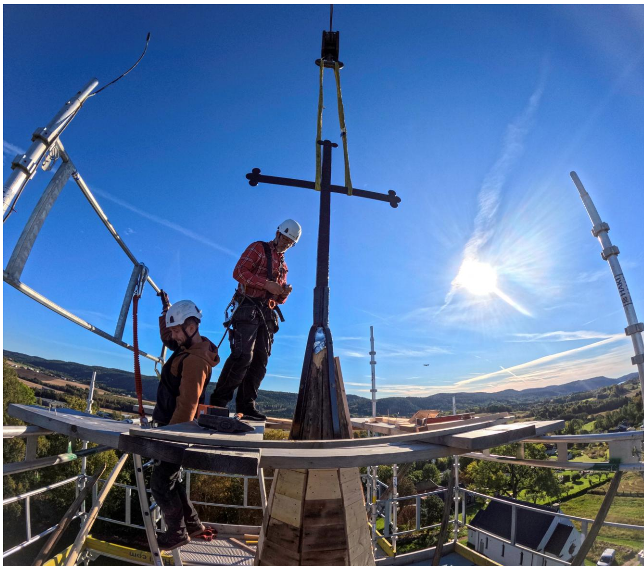
Korset heises tilbake på plass på Hurum kirkes tårn. Nå er tårnet totalrehabilitert og har fått nytt kobbertak. Foto: Pål A. Berg
