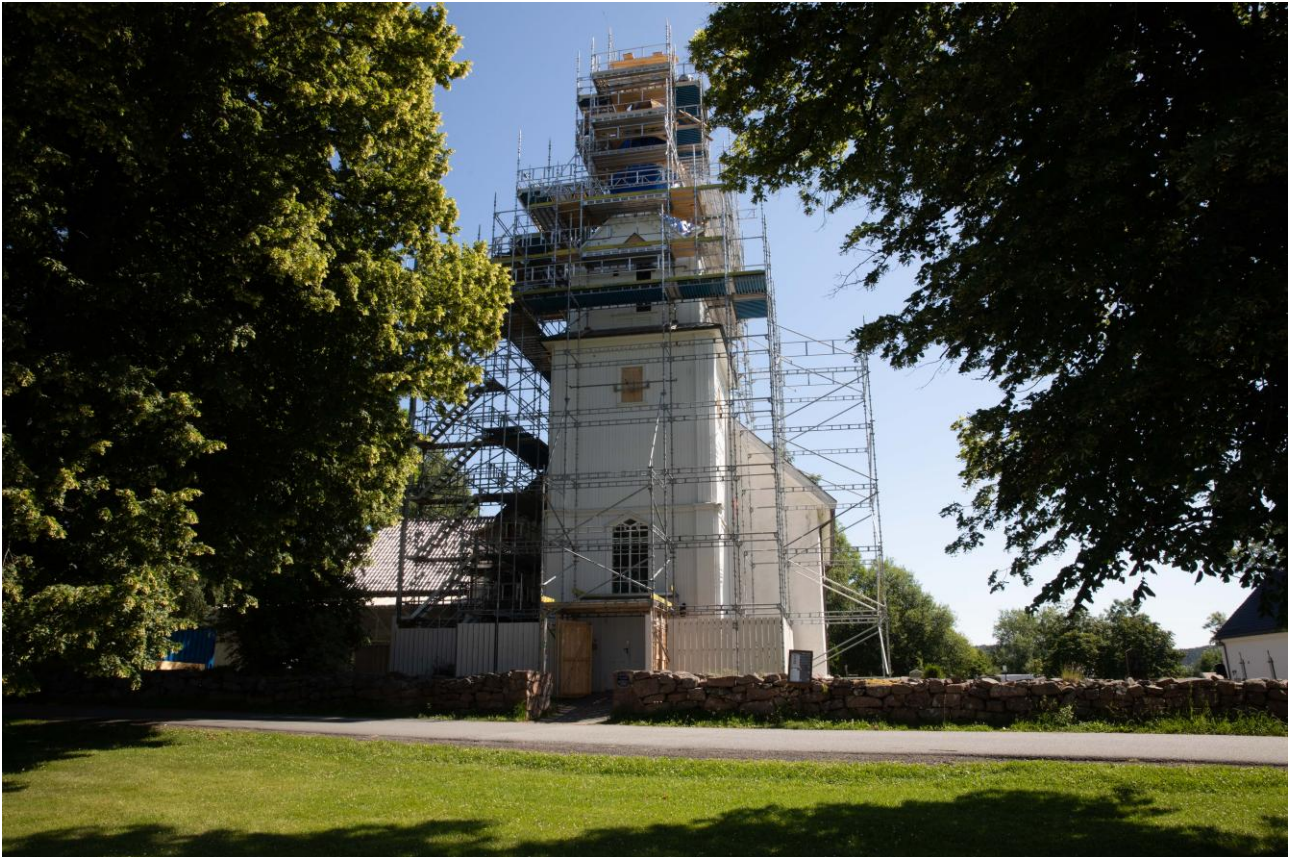
Hurum kirke. Tårnet ble ferdig rehabilitert i 2025. Foto: Pål A. Berg
