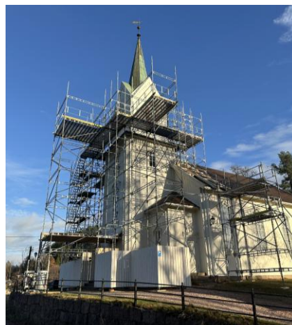
Holmsbu kirkes tårntak er fra byggeåret 1887. I 2026 blir det lagt om, samtidig som kirken får forbedret brannvern, varmeanlegg og universell utforming. Foto: Asker kirkelige fellesråd
