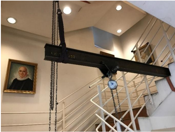
Foto: Høy konsentrasjon og godt samarbeid da mange tonn utstyr skulle lirkes ned kjellertrappa til «fyrrommet» under menighetssalen, 27.03.25. Sogneprest-portrettene i trappeoppgangen fikk bivåne hvordan de tunge delene ble firt langsomt ned – sikret i for-anledning-festede-stålbjelker i trappa. Mens babysang-folket fylte menighetssalen...
