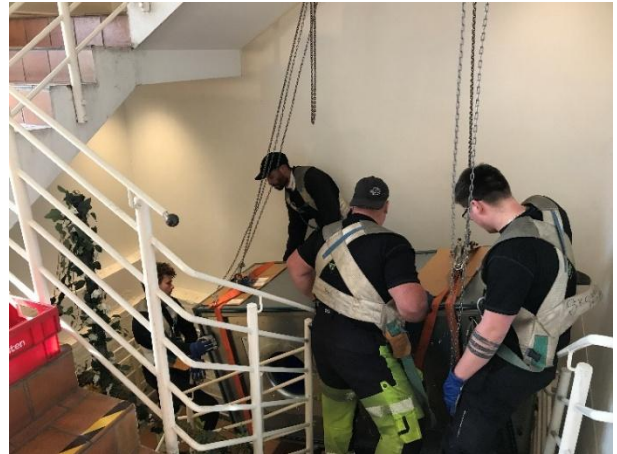
Foto: Høy konsentrasjon og godt samarbeid da mange tonn utstyr skulle lirkes ned kjellertrappa til «fyrrommet» under menighetssalen, 27.03.25. Sogneprest-portrettene i trappeoppgangen fikk bivåne hvordan de tunge delene ble firt langsomt ned – sikret i for-anledning-festede-stålbjelker i trappa. Mens babysang-folket fylte menighetssalen...
