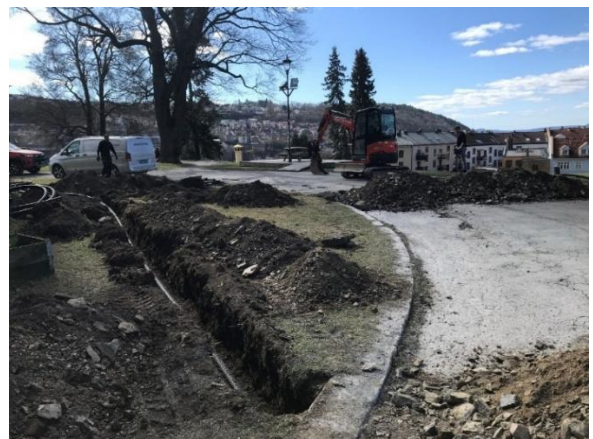
Vannledningene fra de 400 m dype energibrønnene som ble boret i jan-25 føres inn i maskinrommet.
