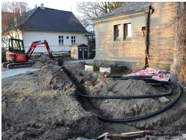
Vannledningene fra de 400 m dype energibrønnene som ble boret i jan-25 føres inn i maskinrommet.
