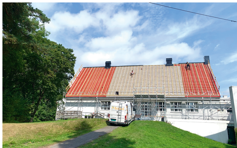
Solcelletaket på Ris menighetshus renoveres ferdig i løpet av de første ukene i september.
